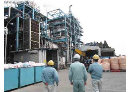
廃棄物処理委託業者現地視察
